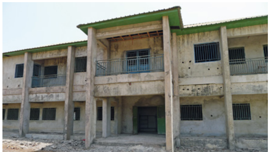
Le chantier du futur laboratoire de police scientifique sur le site de l'école de gendarmerie de Sonfonia. Source : André Desmarais, 5 avril 2019
